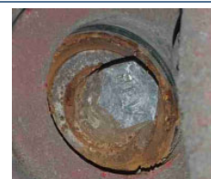
előrehaladott korrózió
