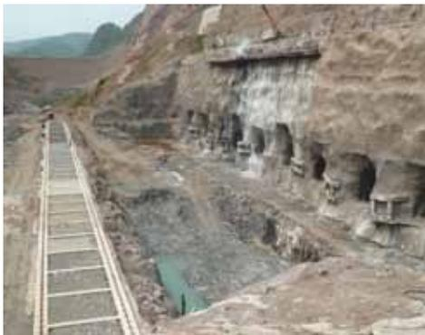
Am Grund der Schlucht wird das Fundament für den Staudamm errichtet.
